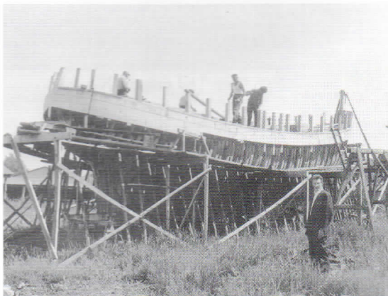
"Mette Kruse" under opbygning
